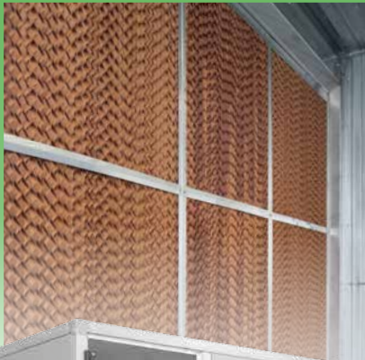
Wabenbefeuchter mit Kaskadenschaltung
